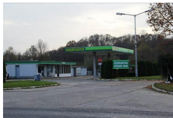
39. kép: A Horváth Autógáz Kft. benzinkútja, palackos gázcseretelep és autógáz töltőállomás
