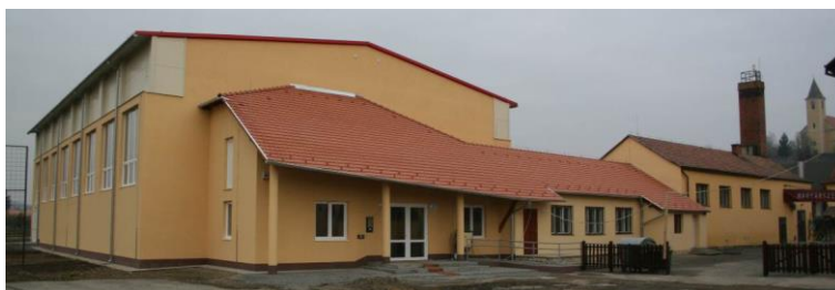
148. kép: Tornacsarnok és öltözők
