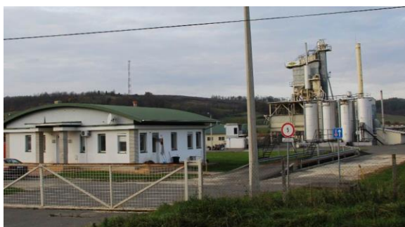
26. kép: A Colas Út Zrt. telephelye az irodaépülettel és az aszfaltkeverő komplexummal
