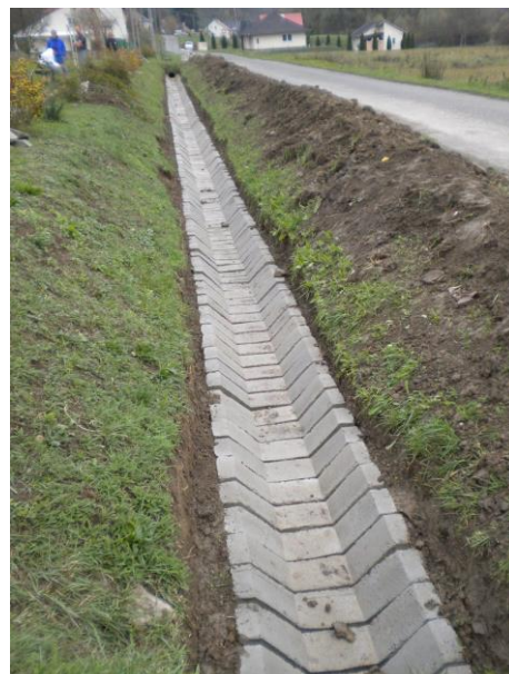
49. kép: Folyamatban lévő árokburkolás
