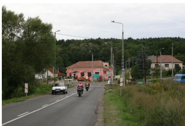
58. kép Vasúti átjáró
