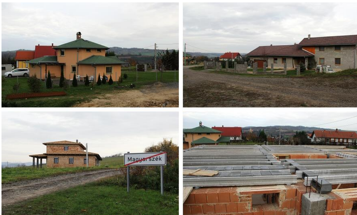
79. kép: Új építésű, épülő többszintes házak a Hársfa utcában
