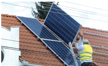
Napelemek telepítése a Nyugdíjas házon
