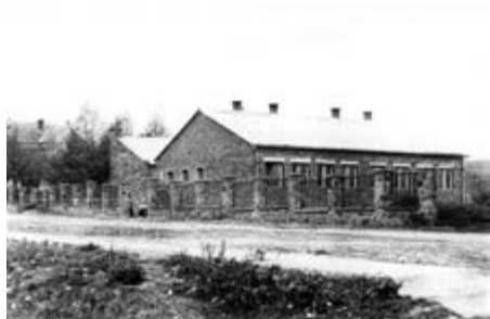
Óvoda építése 1967-ben
