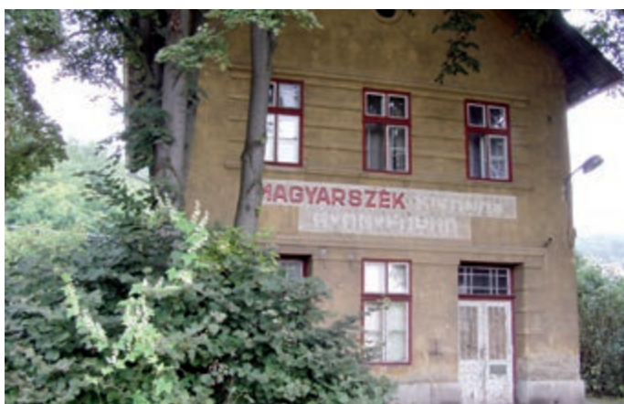
Magyarszék–Síkonda vasútállomás épülete
