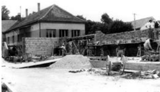
Iskola új szárnyának építése 1986-ban
