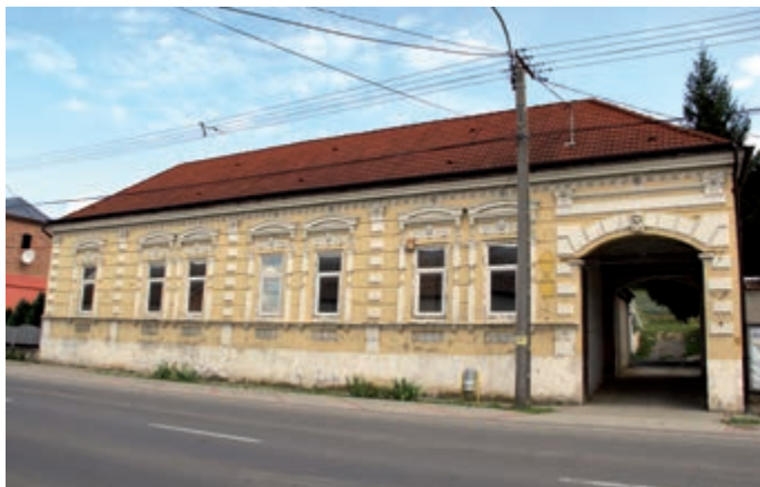
Volt Önkormányzat épületének Ifjúsági szállóvá alakítása
