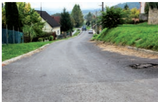
Petőfi utcai aszfaltozás
