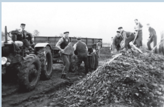
Hunyadi utca köburkolatának építése társadalmi munkában
