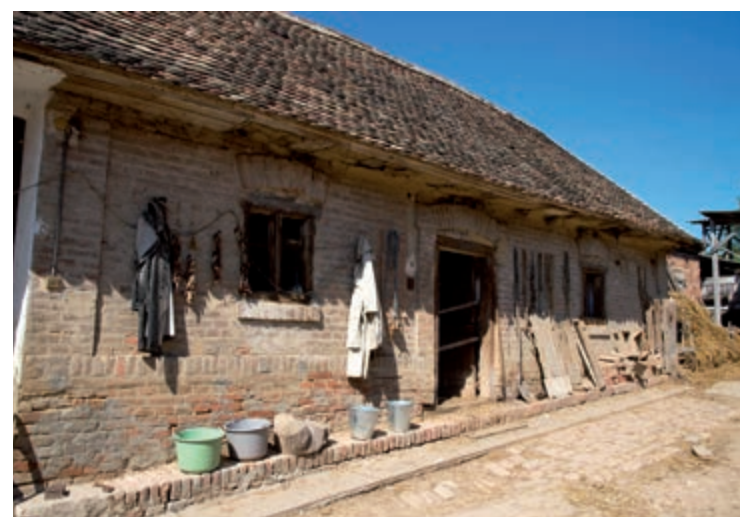
Szemben: fenn, istállóajtó és bontott téglafal; balra lenn: Mekényes rajzolt térképe Fentről lefelé: pajta; pajtatornác oszloptalpa; istálló Jobbra: istállóajtó
