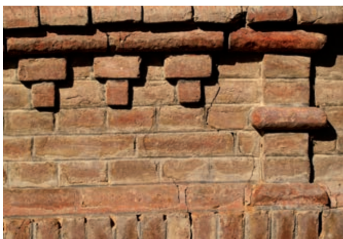
Fenn: pajtahomlokzat-részlet és kovácsoltvas kerítés részlete
