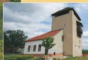
Épített örökségünk a dunaföldvári Csonka-torony
